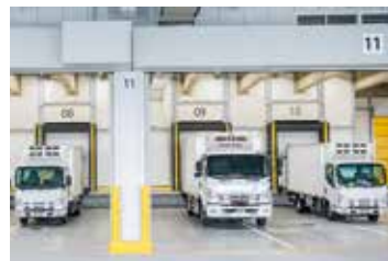
物流センターのドックシェルター
