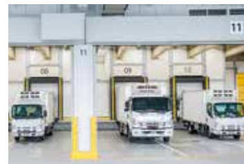
物流センターのドックシェルター
