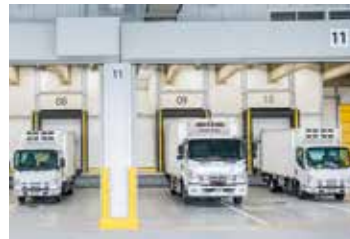
物流センターのドックシェルター
