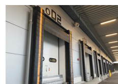
(左) 広島市安佐南区に新設した「TBC広島」とヘリポート。(中)「TBC広島」のピース品(包装単位商品)ピッキングロボット。「TBC埼玉」のものより小型化、省電力化された。(右上)「TBC広島」の保冷車。(右下)ドックシェルター
